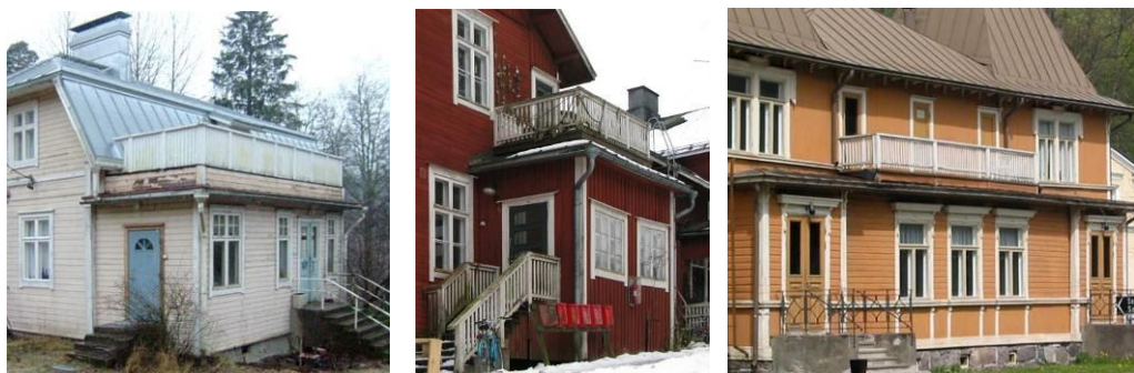
Kuistin päälle rakennettu parveke ei varjosta alapuolella sijaitsevaa ikkunaa. Vasemmalla metsänhoitajan talon (Fiskarsin Linjojen asemakaava, kortteli 83), keskellä Hasselbackan (Fiskarsin Ruukin asemakaava, kortteli 21) ja oikealla Lukaalin parveke (Fiskarsin Ruukin asemakaava, kortteli 11.)
